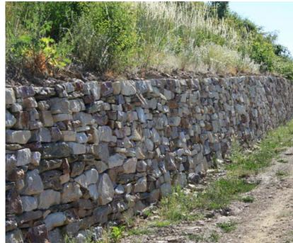
Abb. 10.2 Wiederhergestellte Trockenmauer bei Martinsthal (Foto: RP Darmstadt)
