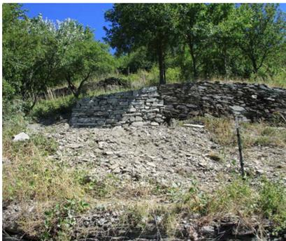
Abb. 10.3 Instandgesetzte Trockenmauer bei Lorchhausen (Foto: RP Darmstadt)
